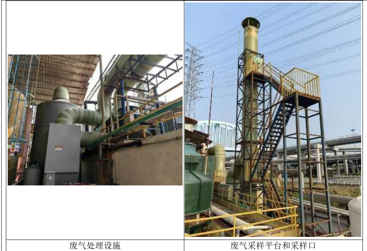
图 3-1 废气处理设施、排放口、采样平台现场照片
