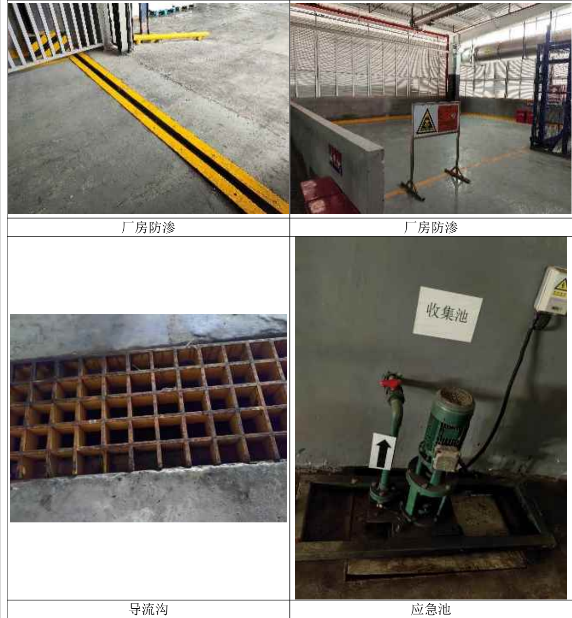
图 3-2 项目危险废物暂存设施
